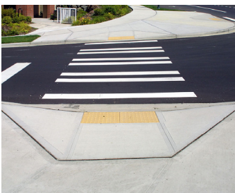
ADA Access Ramp
